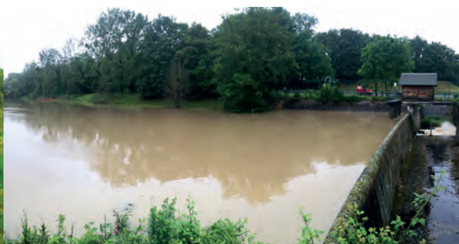
Bassin de Vilgénis amont plein © AESN
